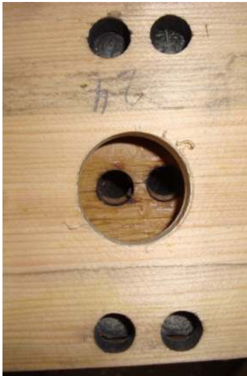
Abb.18 Ausgebauter Subbassstock Untersicht
