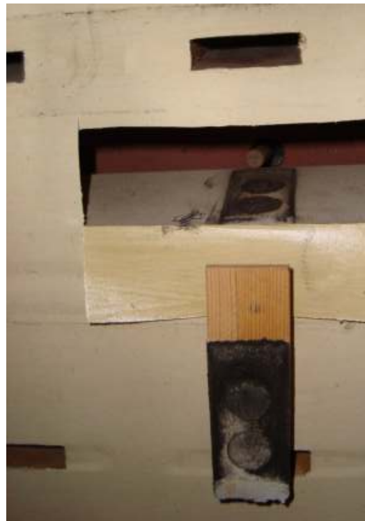
Abb.17 ausgebautes Hängeventil
